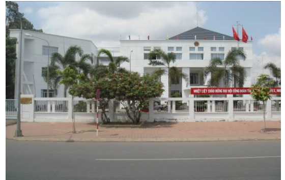
Công trình trụ sở ủy ban thị xã Châu Đốc
